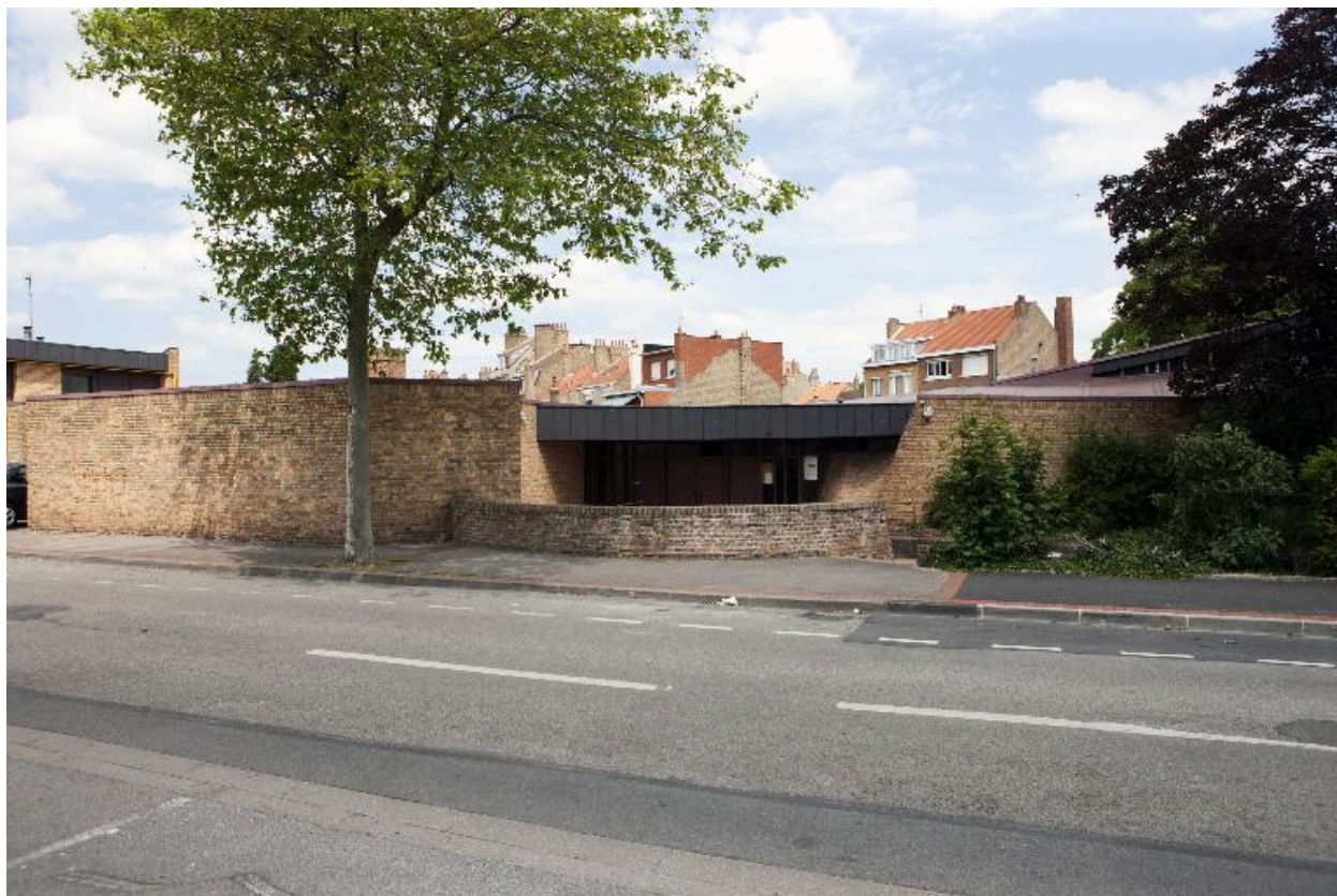
Élévation antérieure de l'église.
