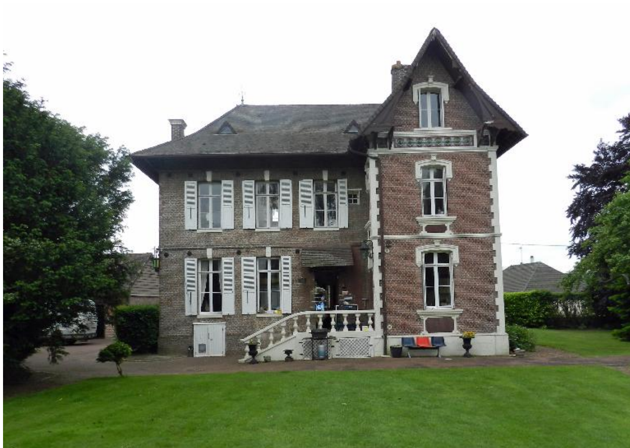
Vue générale de la façade postérieure.
