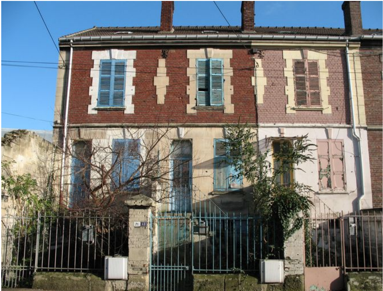
Détail de trois travées de la barre de logements.
