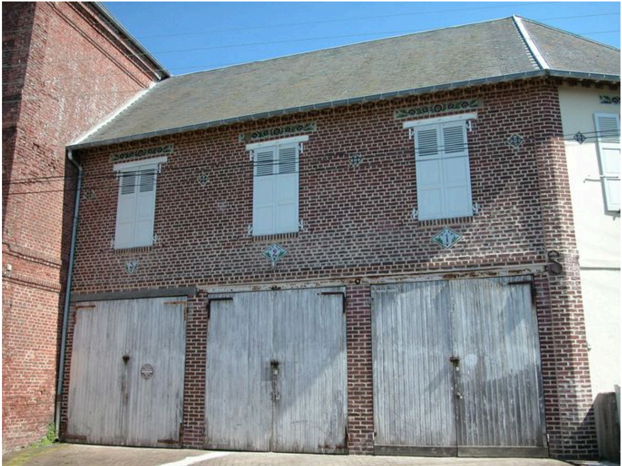
Vue des garages, depuis la rue Gros.
