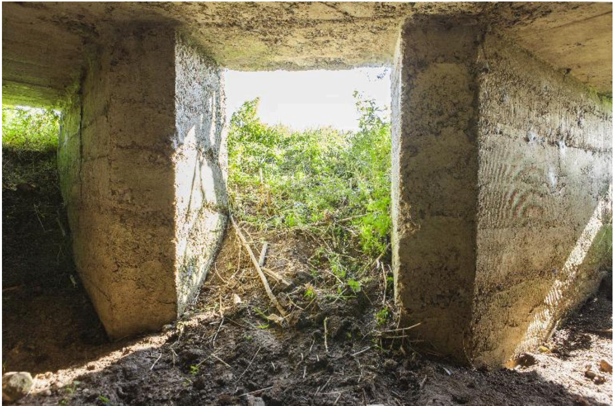
Vue intérieure avec, de gauche à droite, les entrées sud-est, sud et sud ouest
