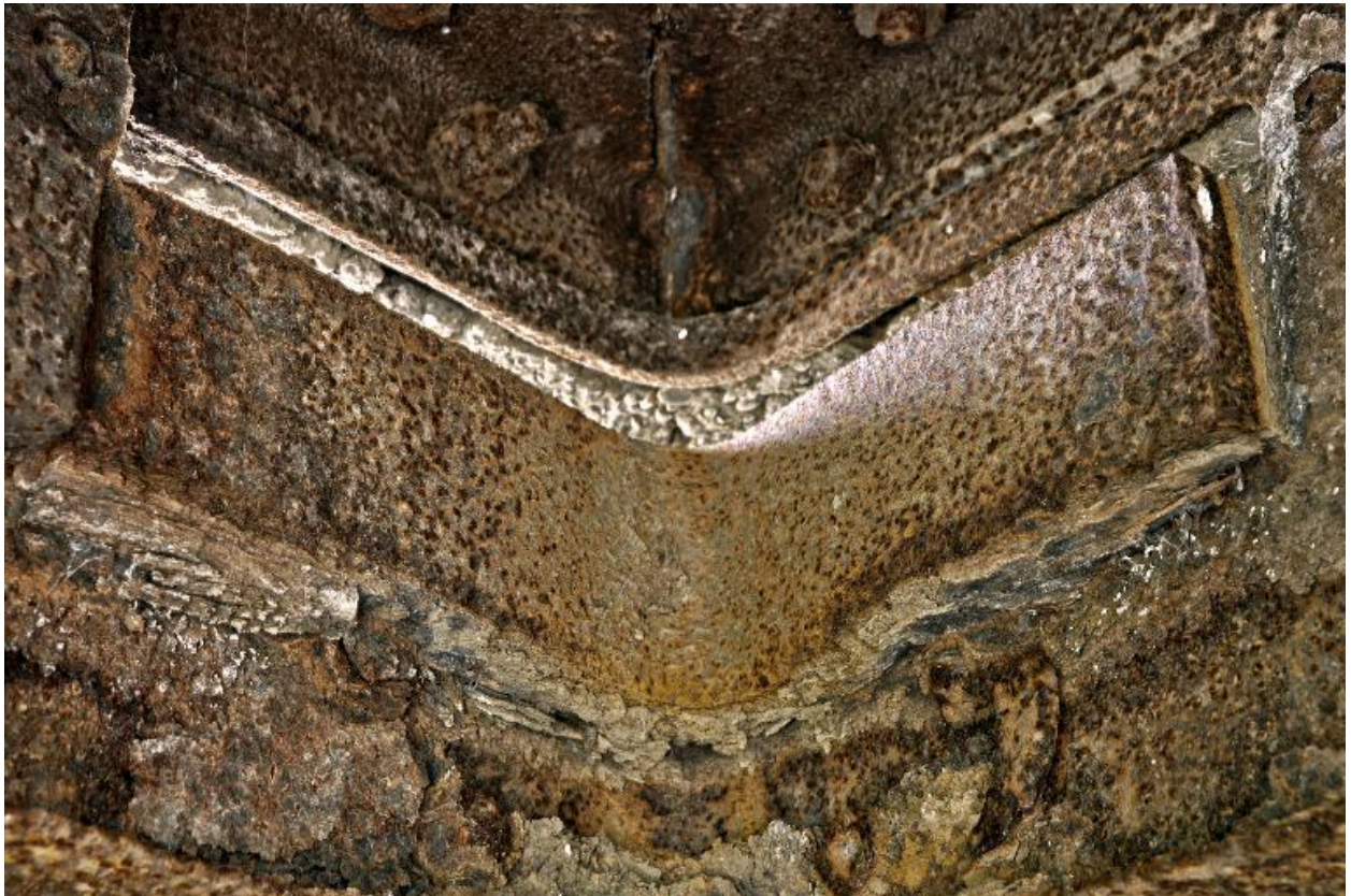
Observatoire casematé, détail intérieur
