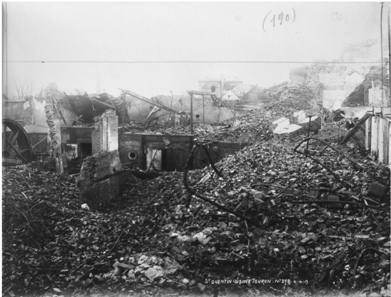
Le site de la filature en avril 1919 : salle des machines - générateurs - cheminées (AD Aisne).
