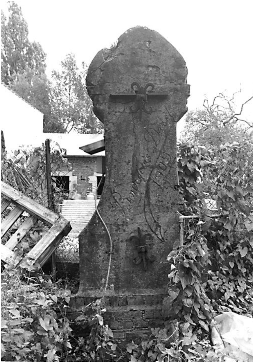
Puits de style Art Nouveau : élévation postérieure avec la signature 'Daret-Bourgeois 1909'.
