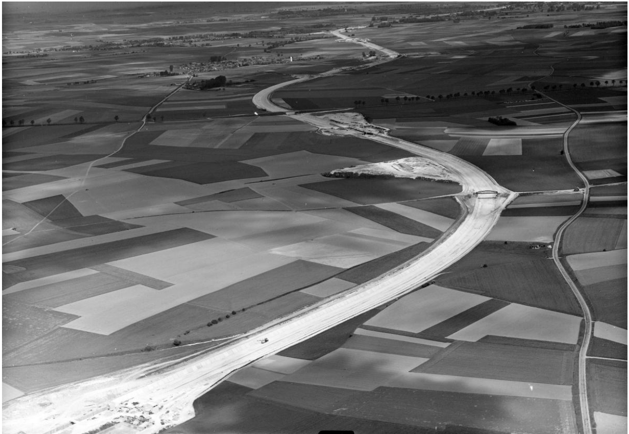
Vue aérienne du secteur de l'écluse n°7 de Graincourt-les-Havrincourt (Pas-de-Calais) lors de l'achèvement des travaux du canal. (IGN. Photothèque Nationale : 1965).
