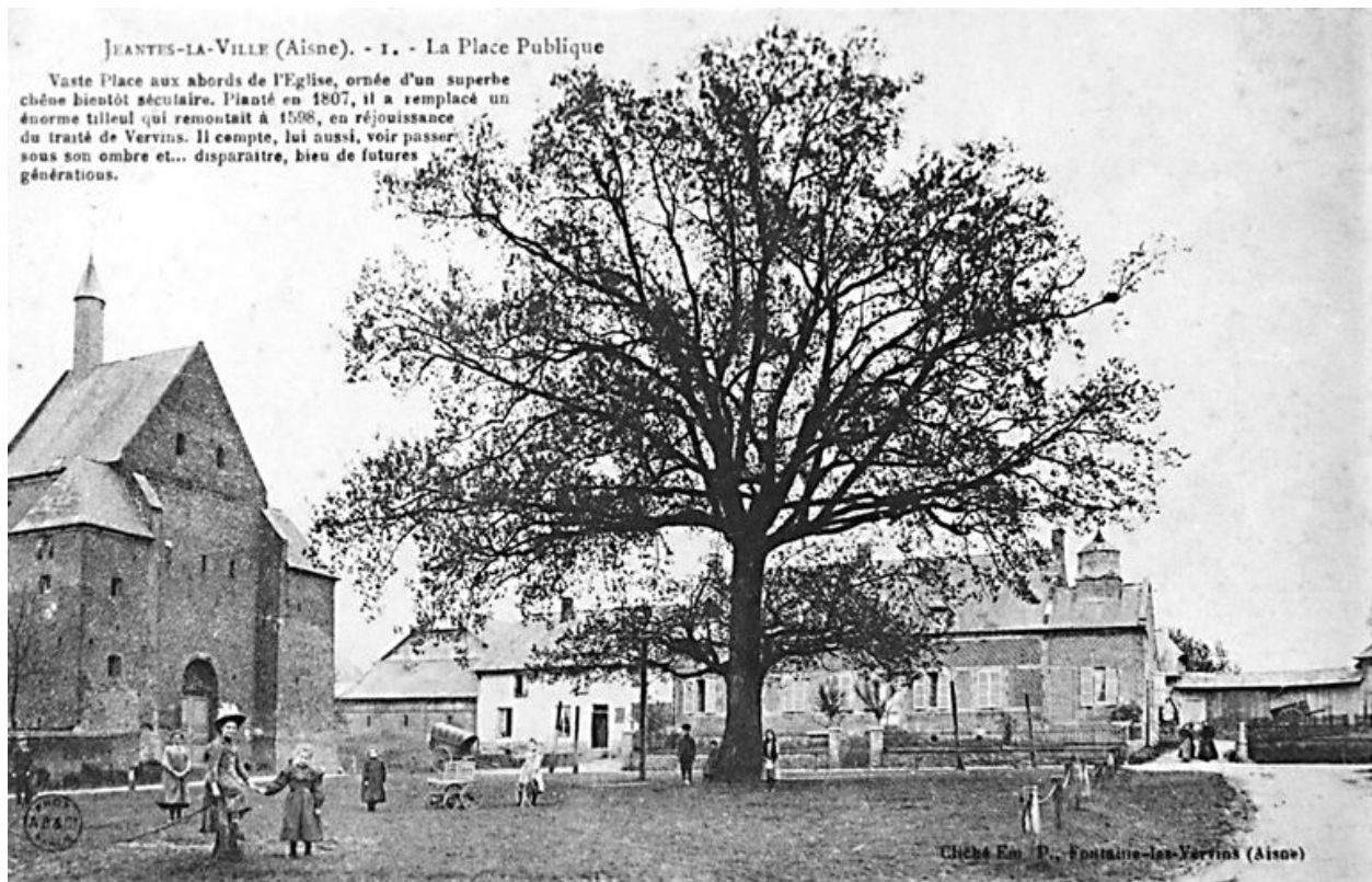
Façade occidentale de l'église donnant sur la place publique (AP).
