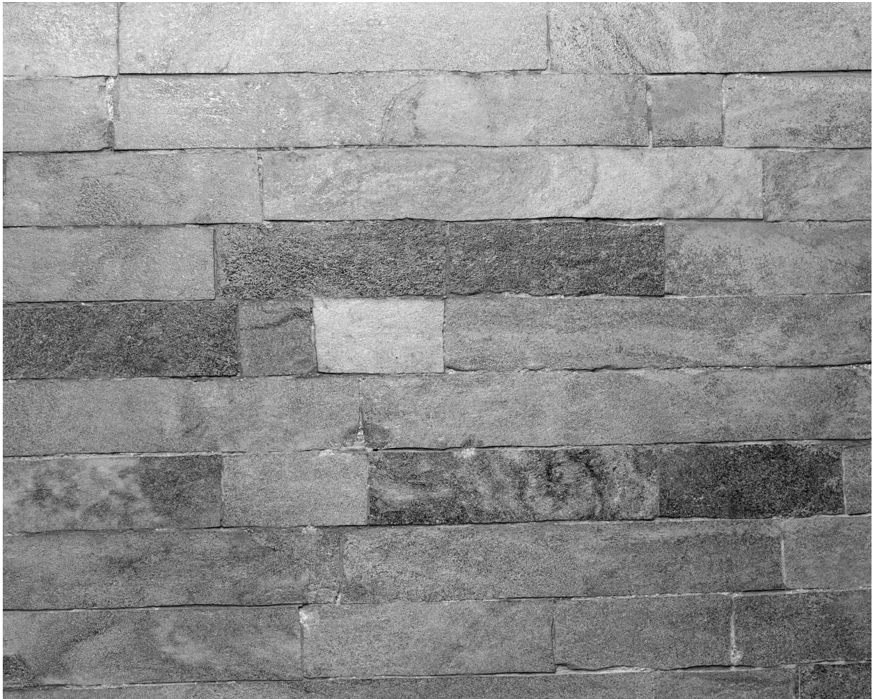
Détail du soubassement du bas-côté : les plaquettes de pâte de verre.
