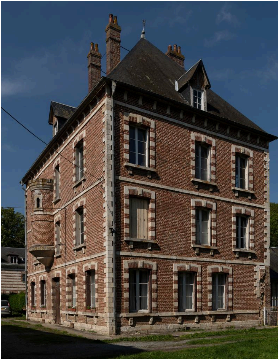
Vue du pavillon sud depuis l'est.
