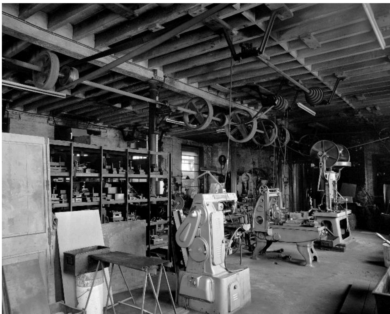
Atelier de fabrication, vue intérieure, en 1988.
