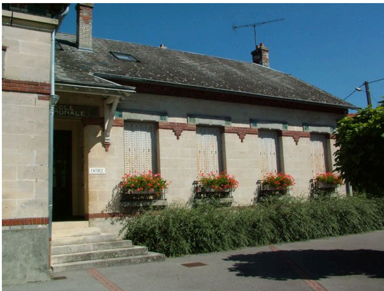
Vue des bâtiments scolaires.
