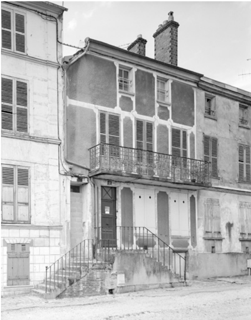
Maison, 12 avenue Joussaume-Latour.
