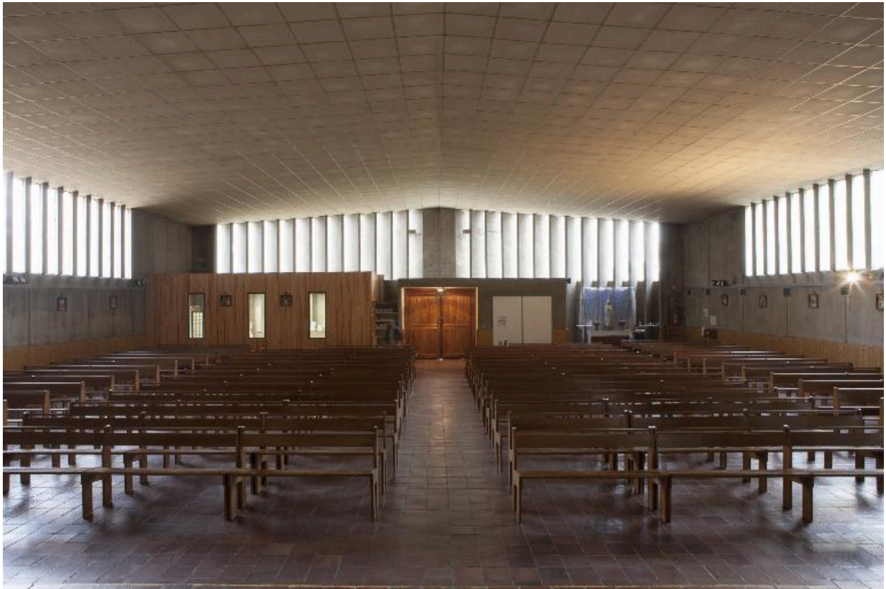
Vue générale depuis le chœur.
