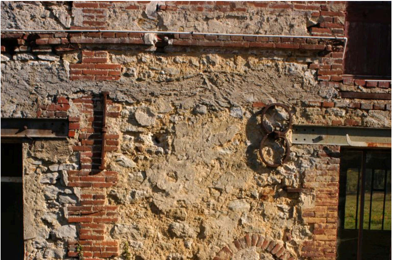
Détail de la date partielle en fers d'ancrage sur le mur ouest de l'atelier de fabrication.
