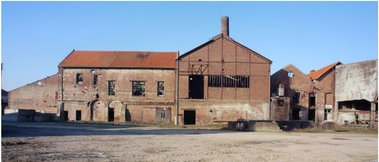
Vue d'ensemble des façades postérieures (est) des ateliers de fabrication.
