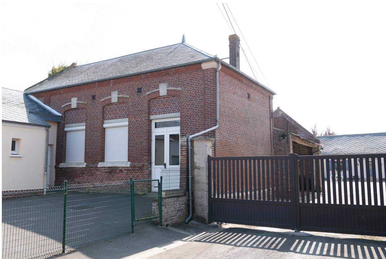
Ancienne école, n°21 de la rue de la Mairie, vue depuis le nord.
