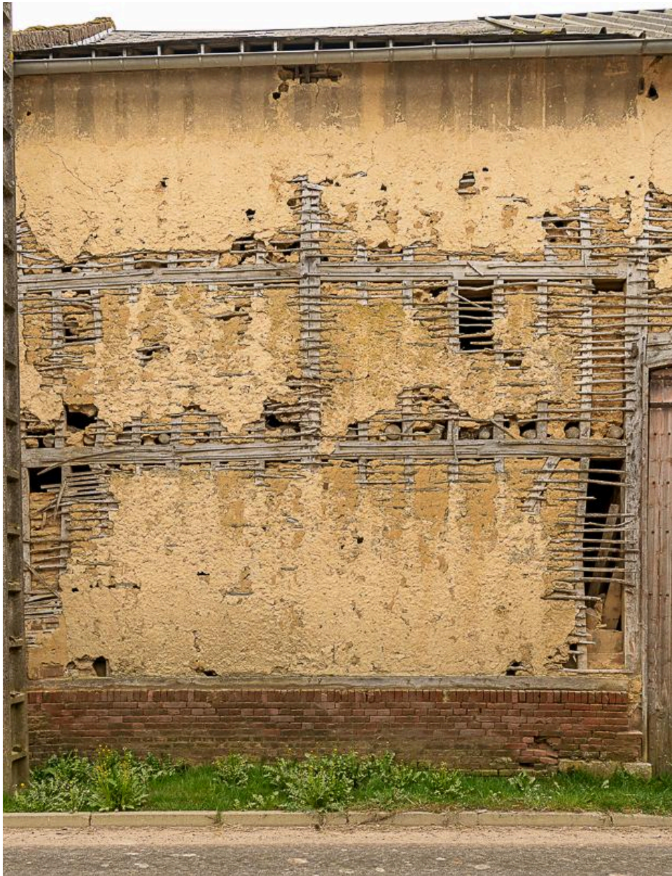
Détail de la mise en oeuvre en torchis et pans de bois de la grange n°10 Grande Rue.
