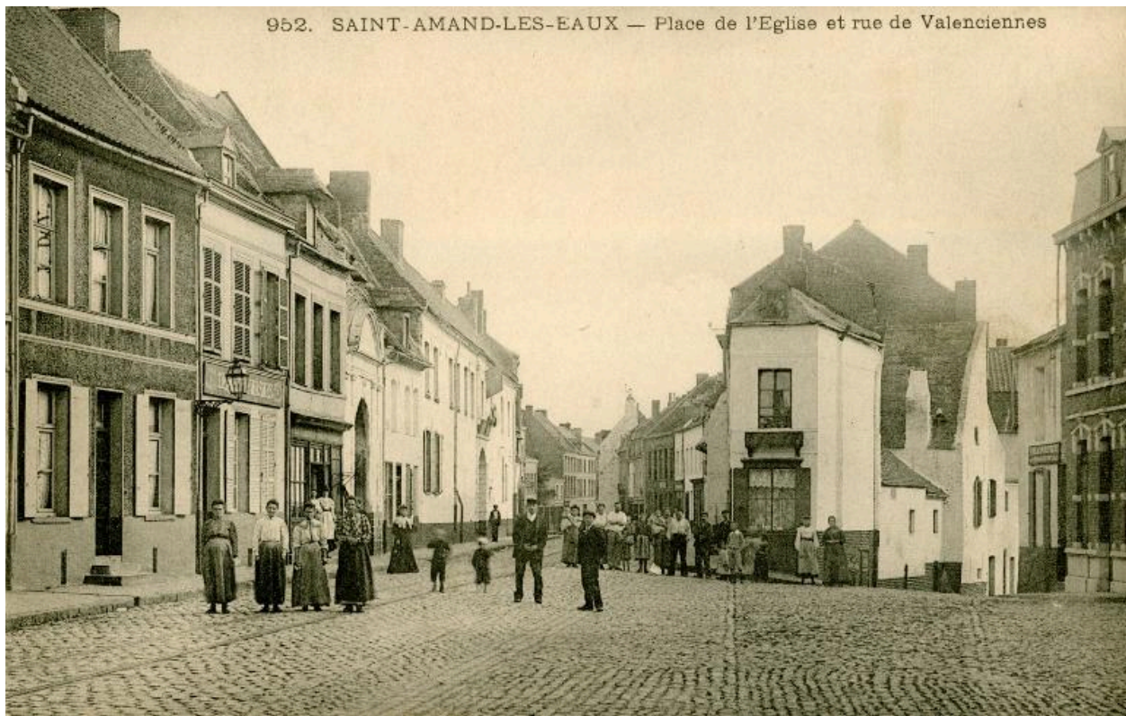
La rue de Valenciennes, au croisement avec la rue du Wacq, carte postale sans date (Médiathèque Saint-Amand-les-Eaux).
