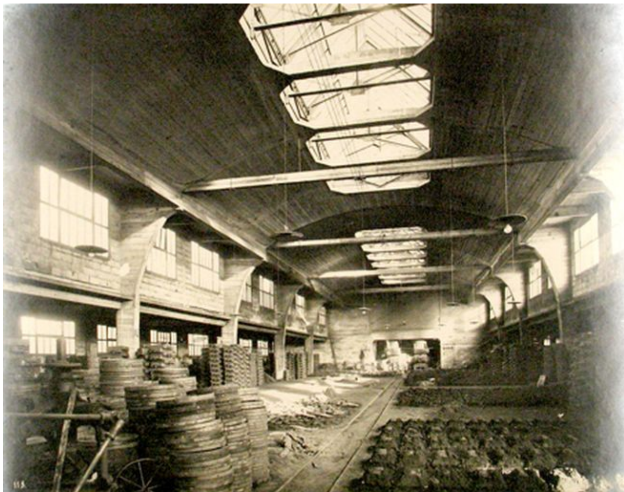
Intérieur de la fonderie construite par les architectes Perret au milieu des années 1920 (IFA ; 535 AP 651/12).
