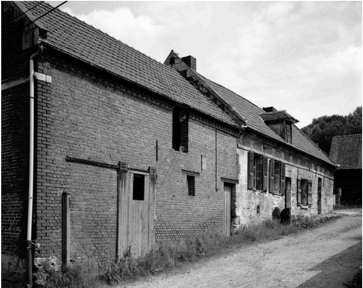
Etable à chevaux et logis. Vue générale.
