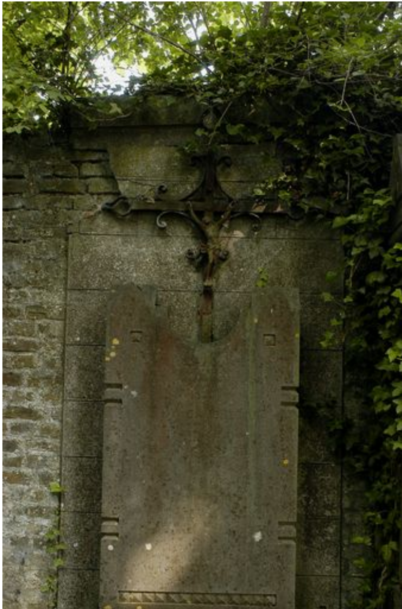
Vue de la partie supérieure de la stèle et de la croix à l'arrière-plan.
