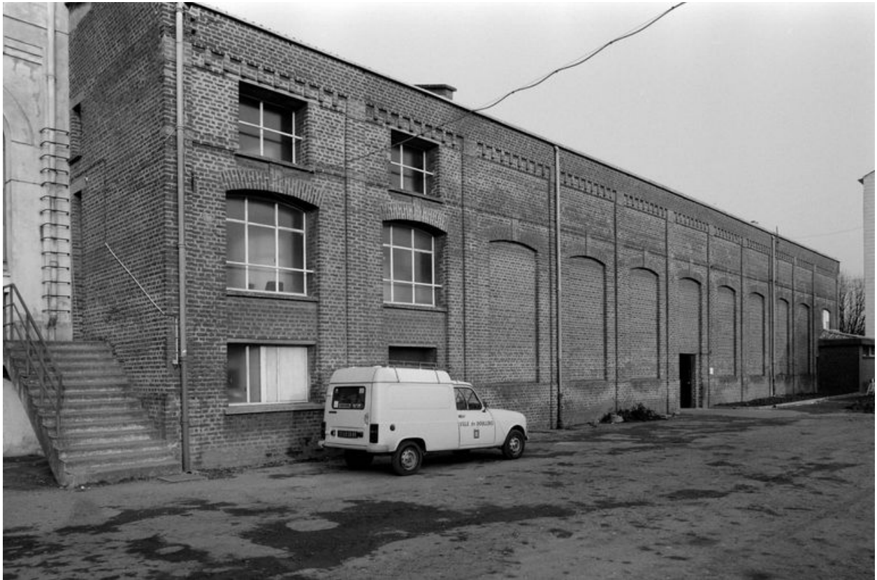
Atelier de fabrication est, en 1991 : élévation est.
