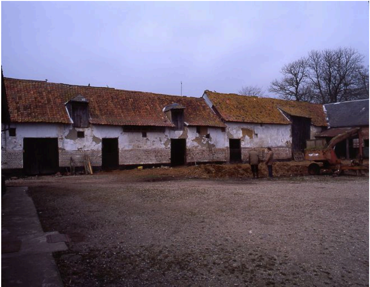
Vue des étables et de la grange sur le côté nord de la cour.
