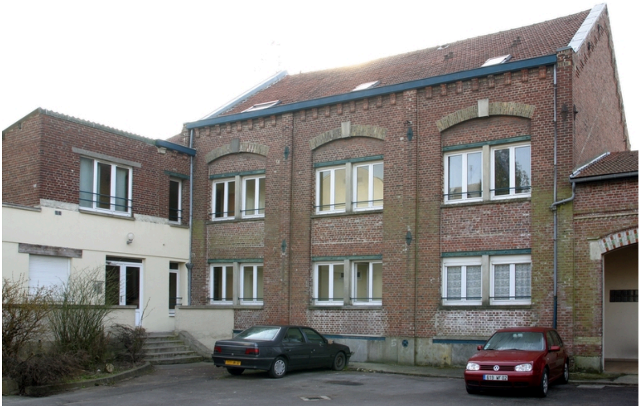
Façades postérieures des anciens bobinage et retorderie.
