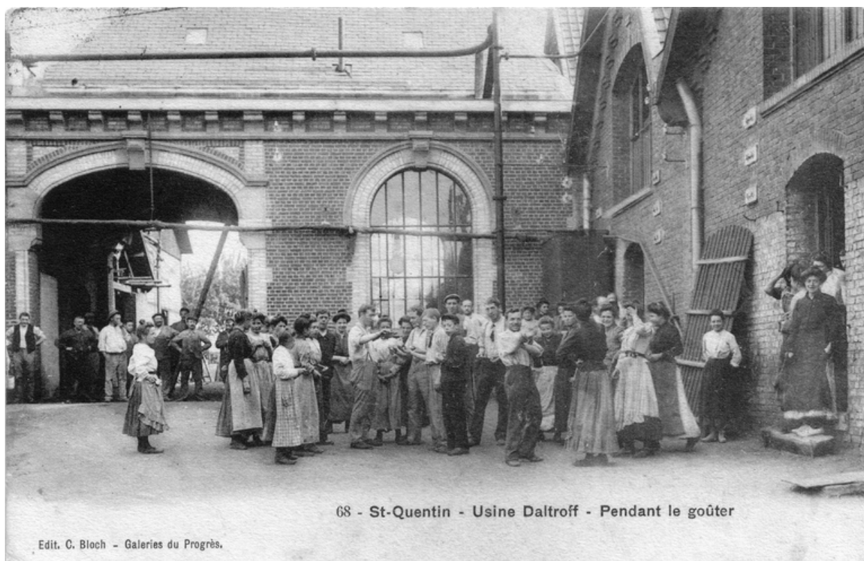
Ouvriers devant la salle des machines (BM Saint-Quentin).
