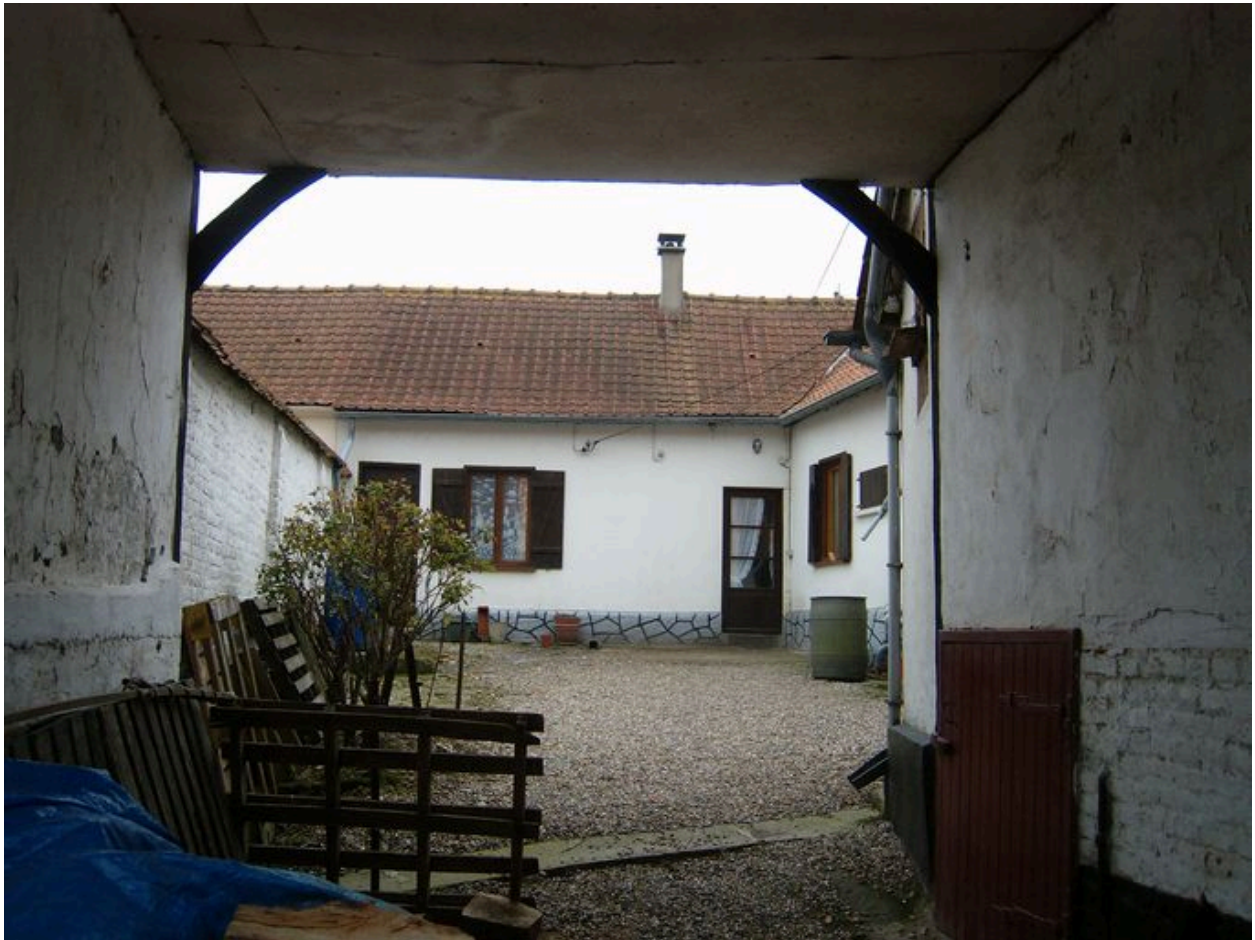
Vue du logis du n°18.
