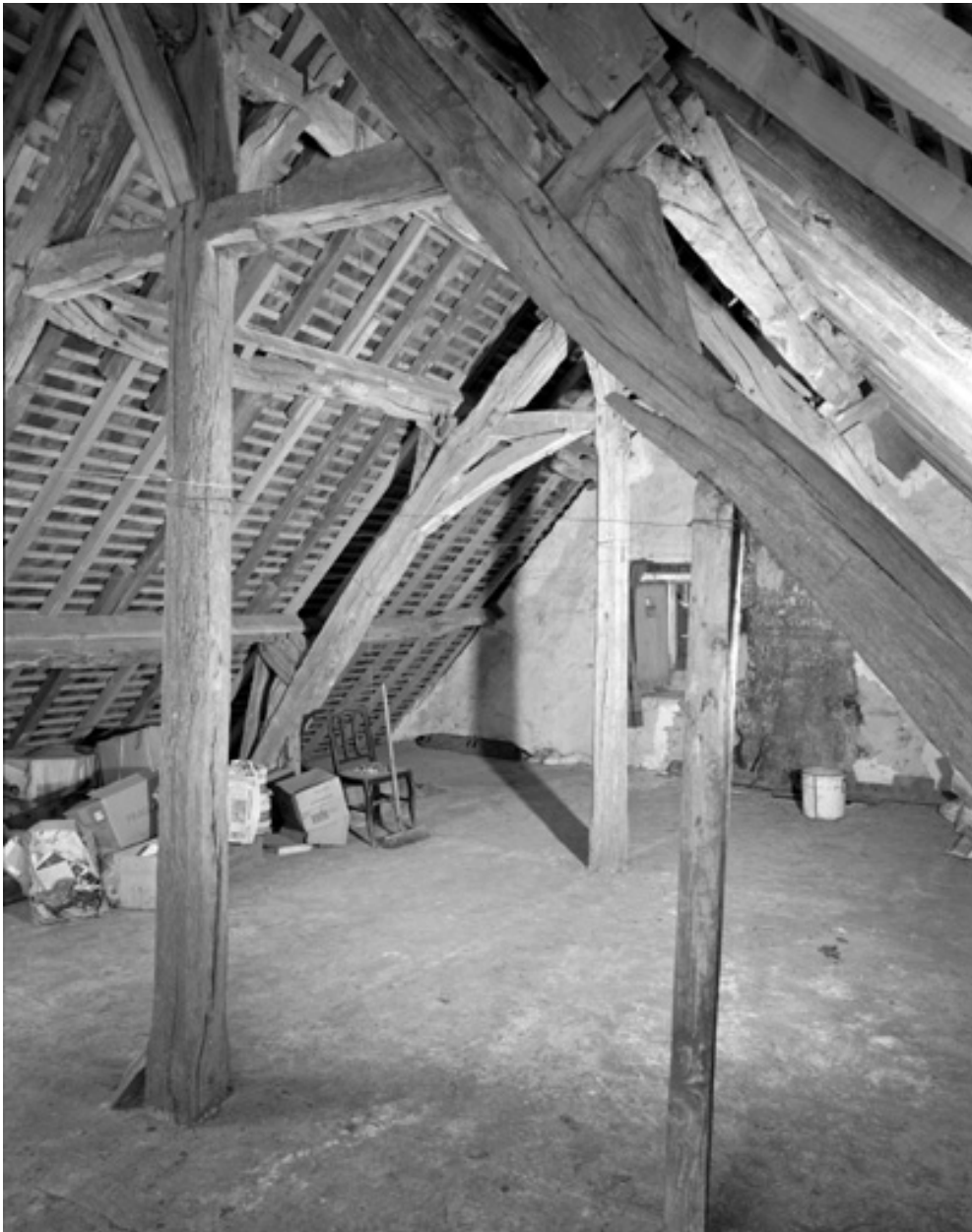
Vue de la charpente.
