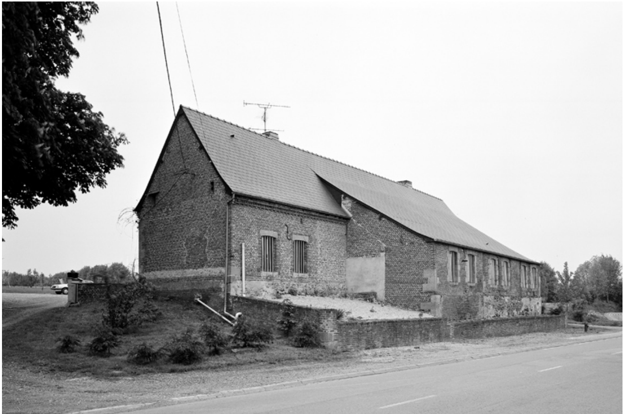
Le logis, depuis le nord-est.
