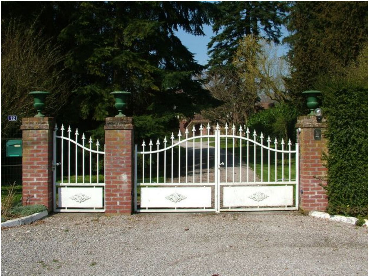
Portail principal ouvrant sur la rue de l'Eglise.
