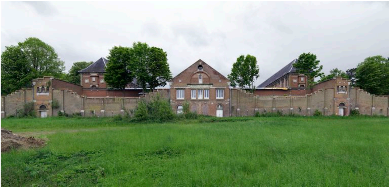
L'ancien pensionnat et le mur de clôture, vus depuis le sud.
