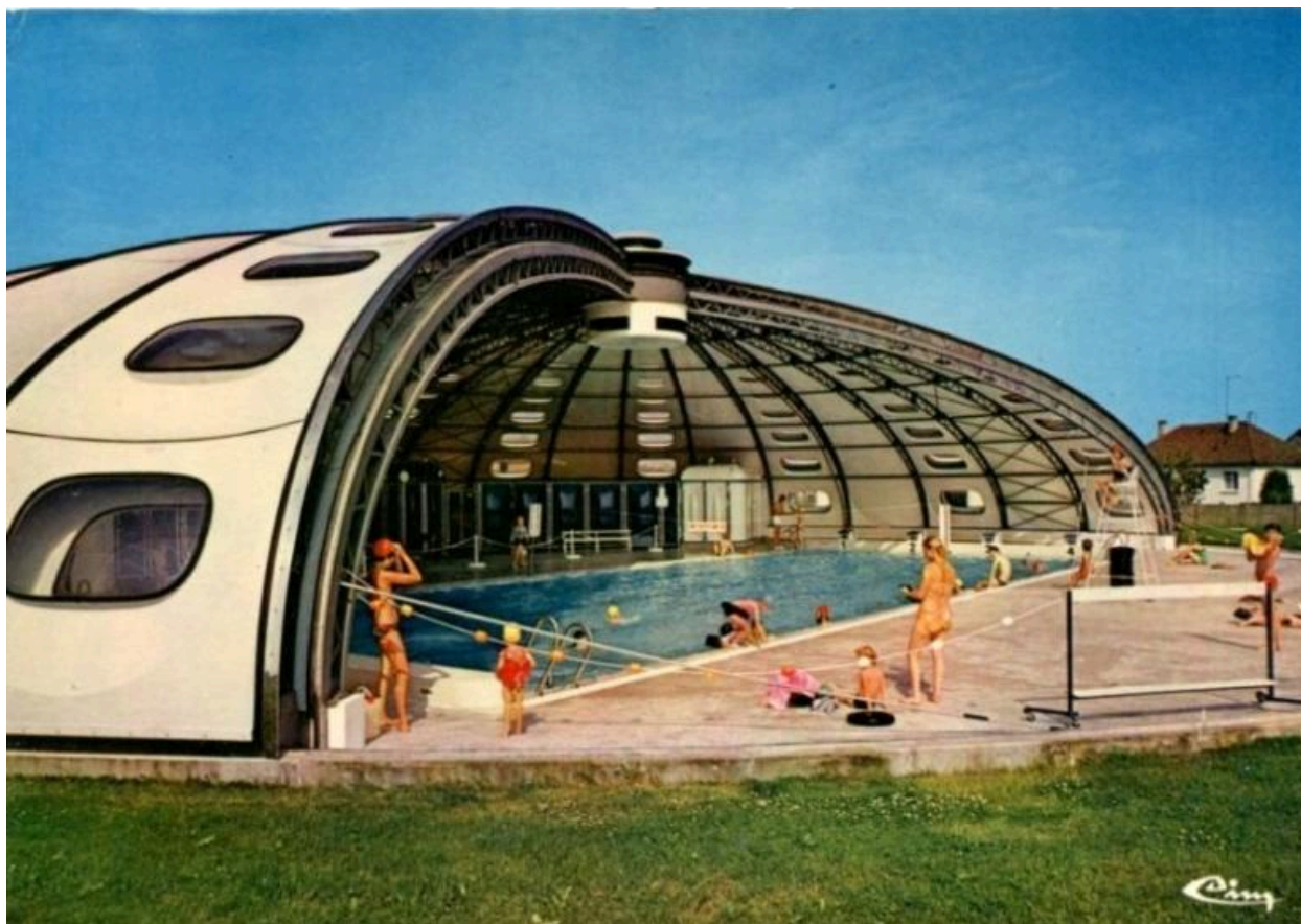
La piscine Tournesol de Formerie en position ouverte, carte postale, vers 1975 (coll. part.).
