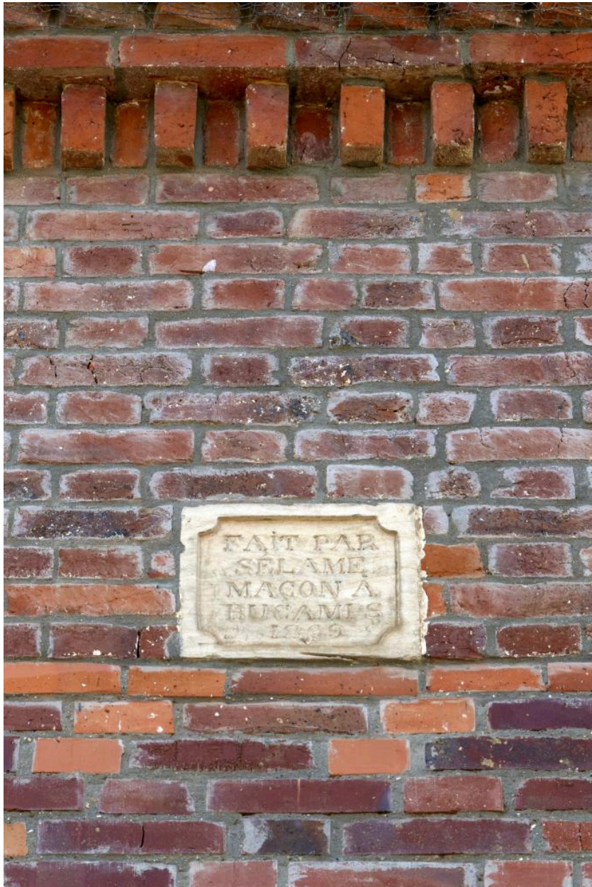
Détail de la signature du maçon, M. Sélame à Bucamps, pignon est du n°19 rue du Chauffour.
