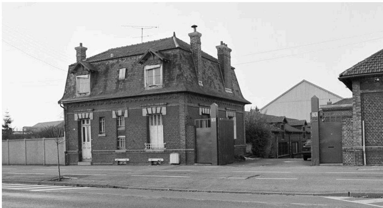
Conciergerie : élévation antérieure.
