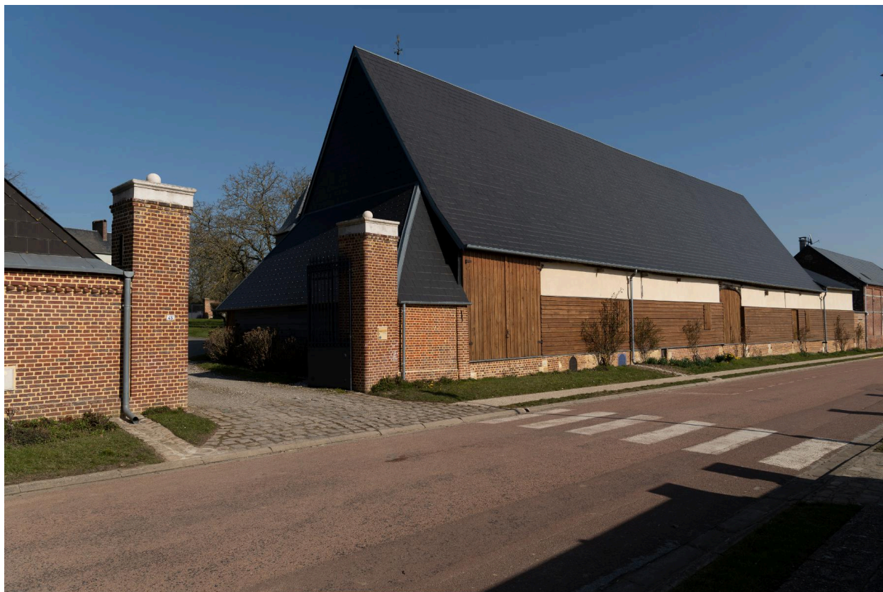
Grange sur rue de la ferme de la Neuve Rue (voir dossier), n°45 de la Neuve-Rue, vue prise depuis le sud.
