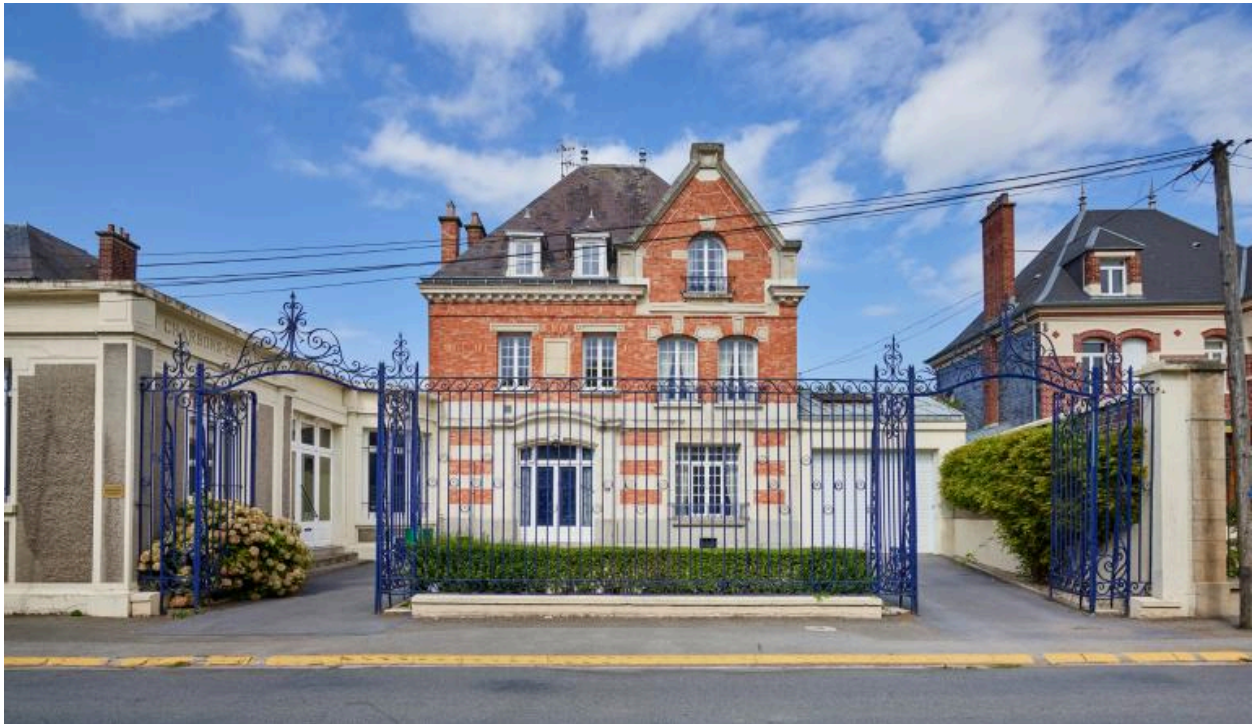
Maison de maître, n° 10 rue de Douai. Maison de style néo-classique Louis XIII, installée en fond de cour.
