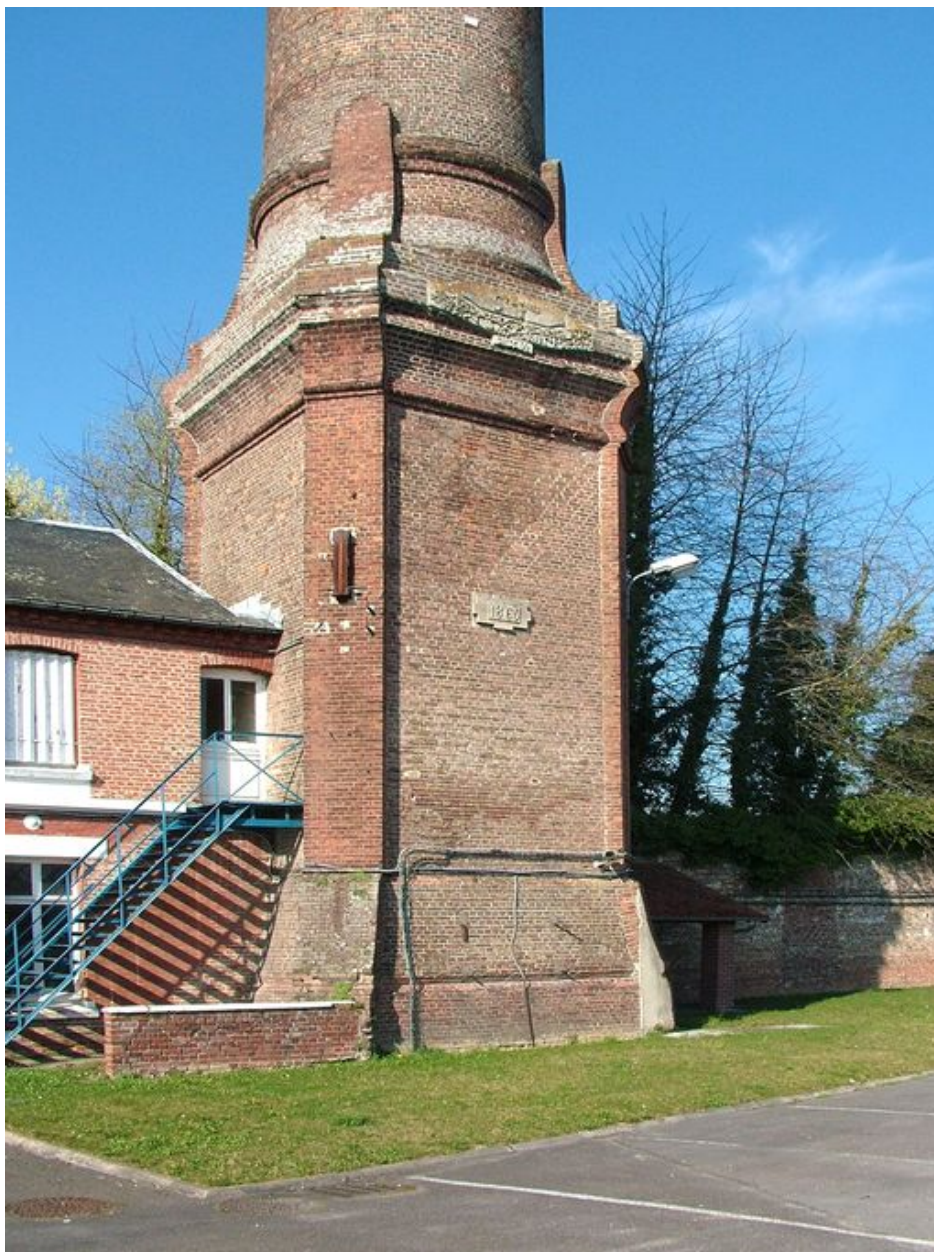
Partie inférieure de la cheminée d'usine portant la date de 1865.
