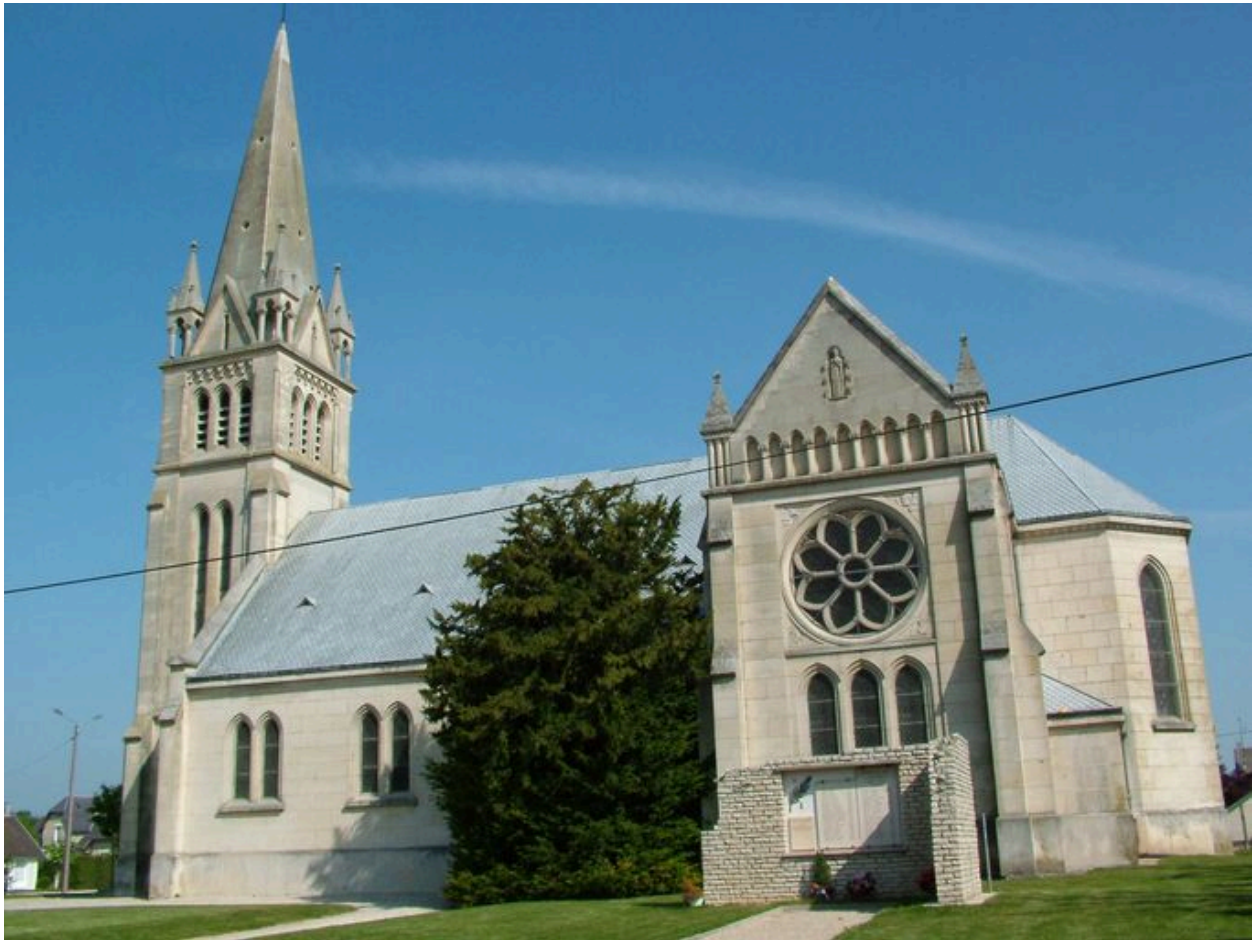
Vue de la face sud.
