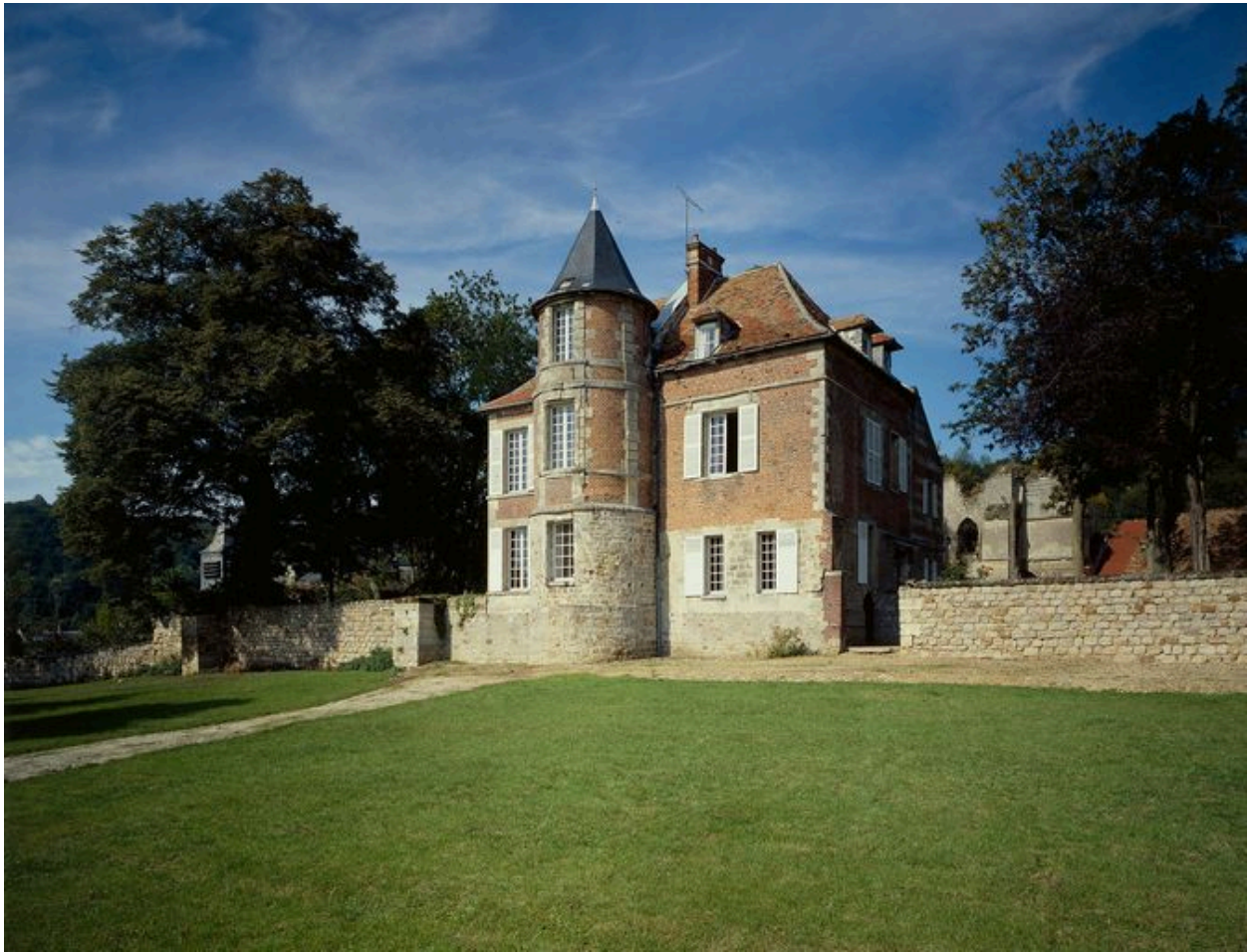
Logis. Vue générale.
