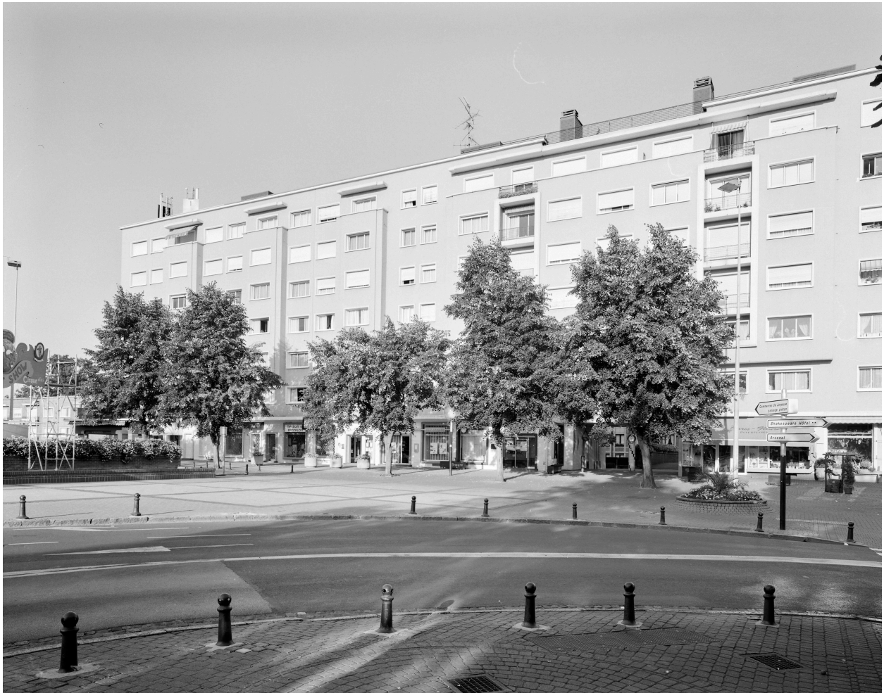
Vue partielle de l'élévation sur la place des Nations, vers le square Lafayette.
