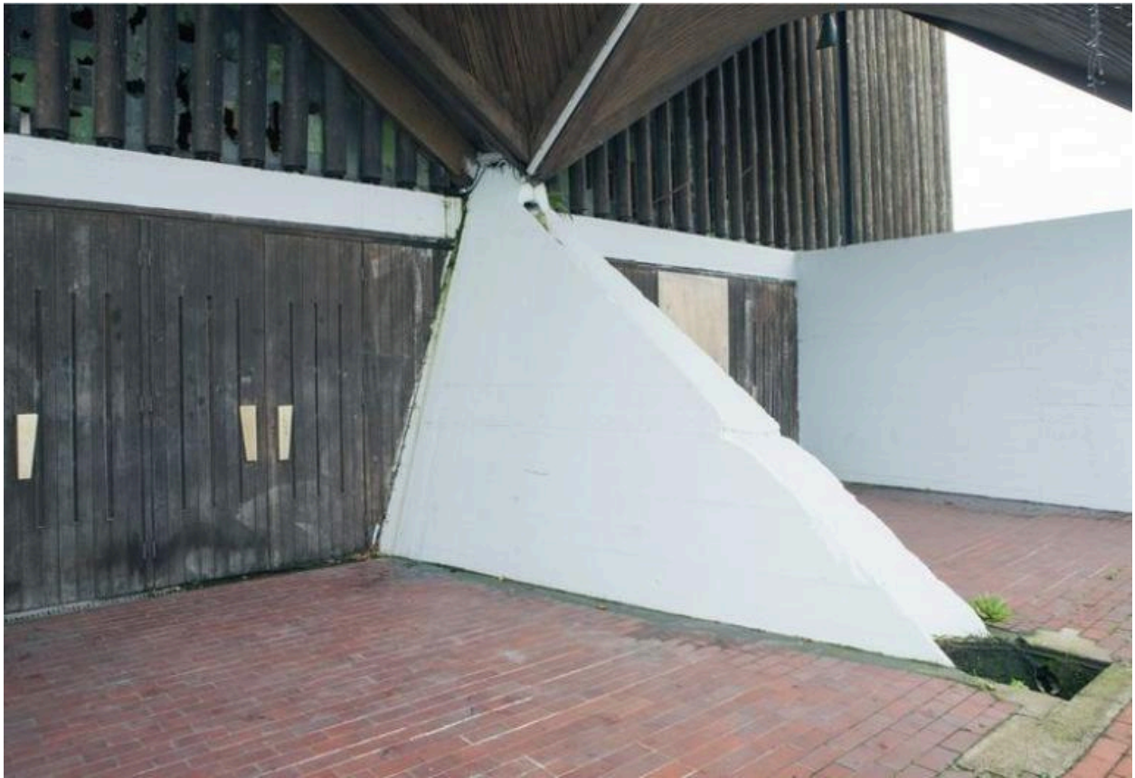
Vue de trois quart gauche de l'entrée.
