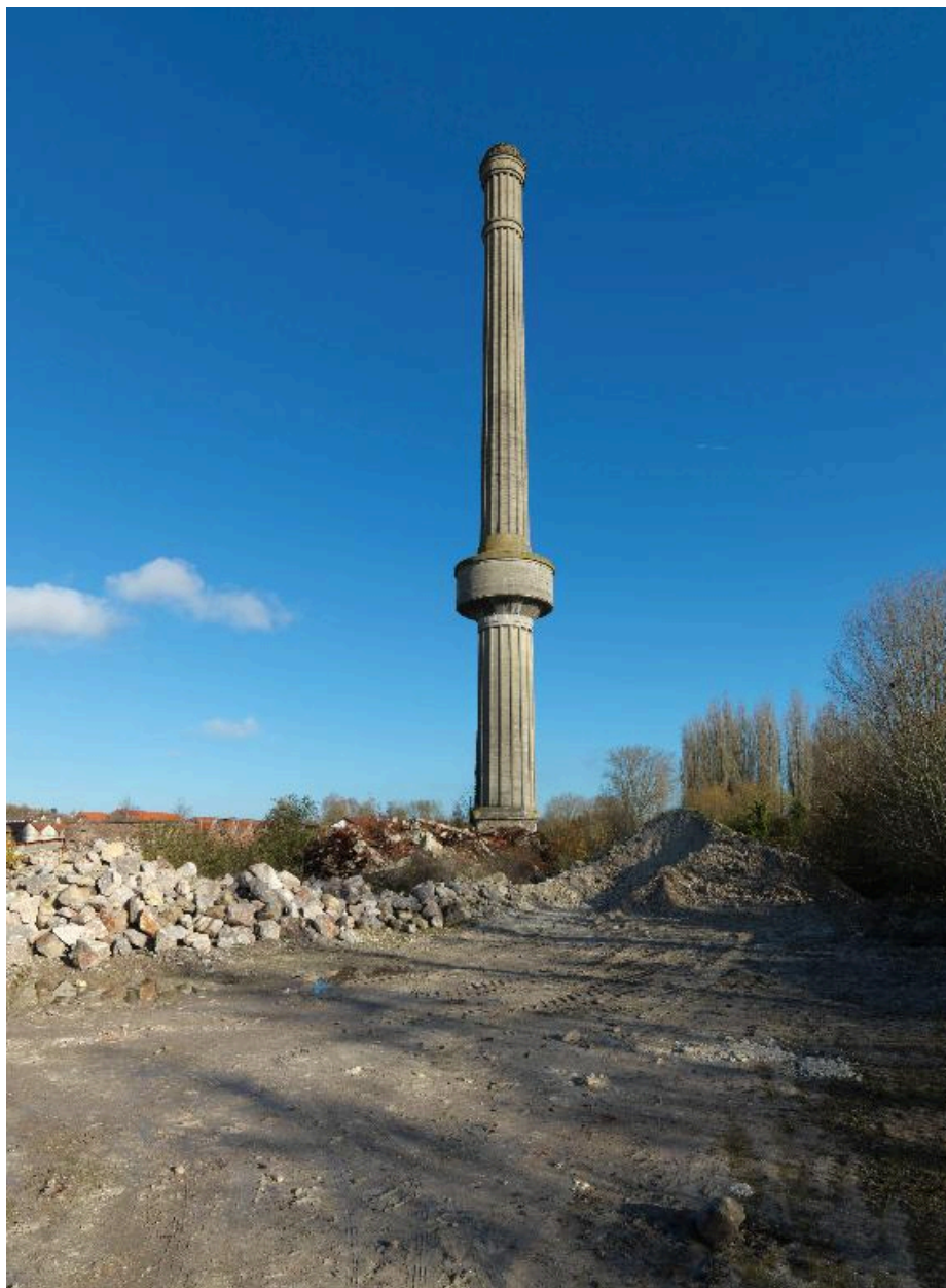
Cheminée en béton et gravats de l'ancienne centrale thermique démolie.
