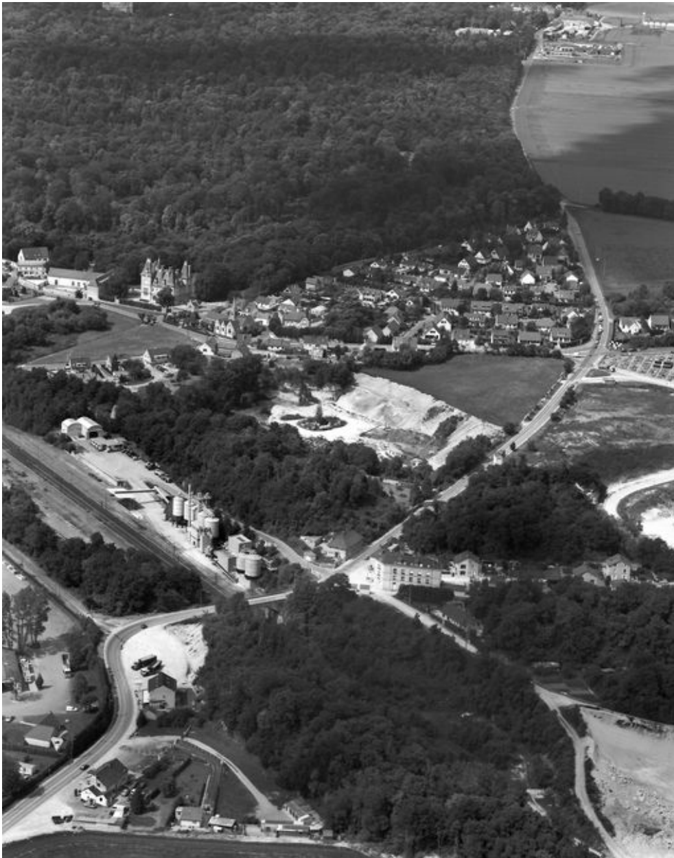
Vue aérienne vers 1995, au centre l'économat des carriers.
