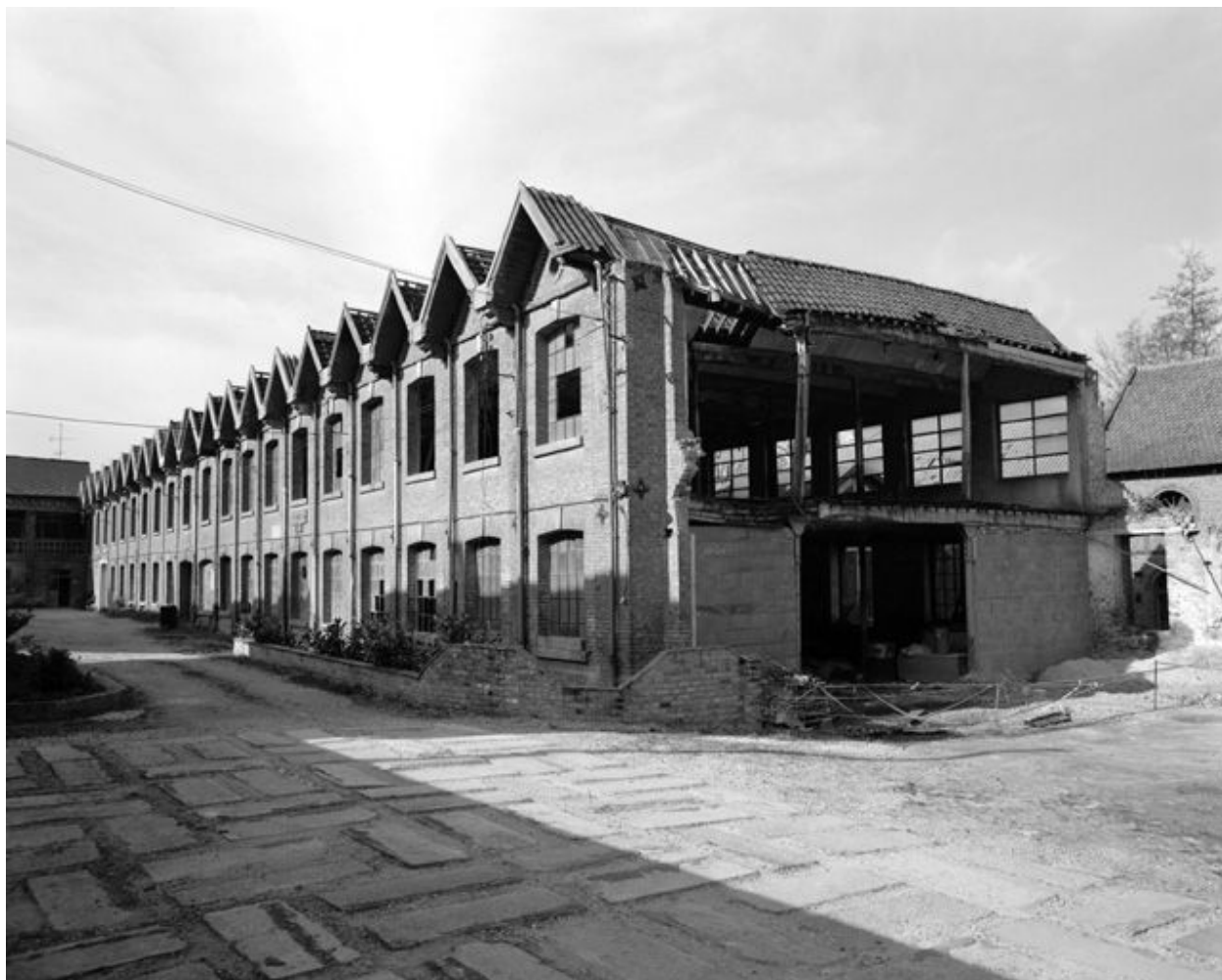
Atelier de fabrication, flanc nord-est.
