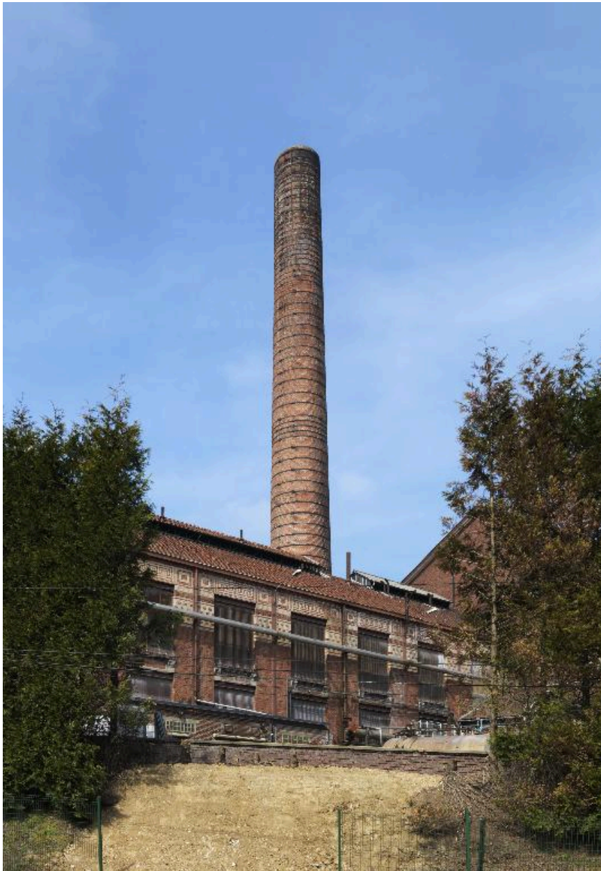
Vue de la façade longitudinale ouest de l'atelier principal de fabrication.
