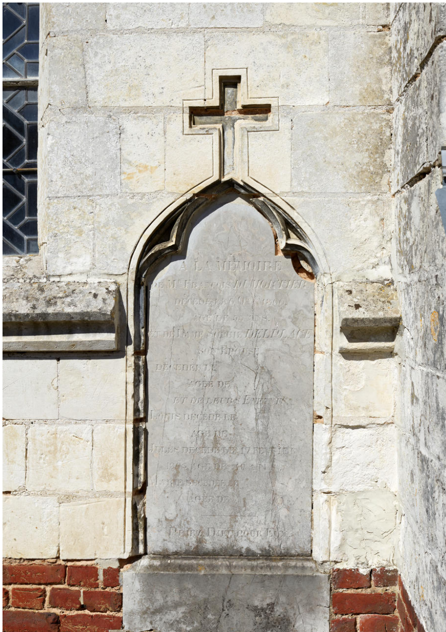
Plaque funéraire sur l'élévation sud de l'église.
