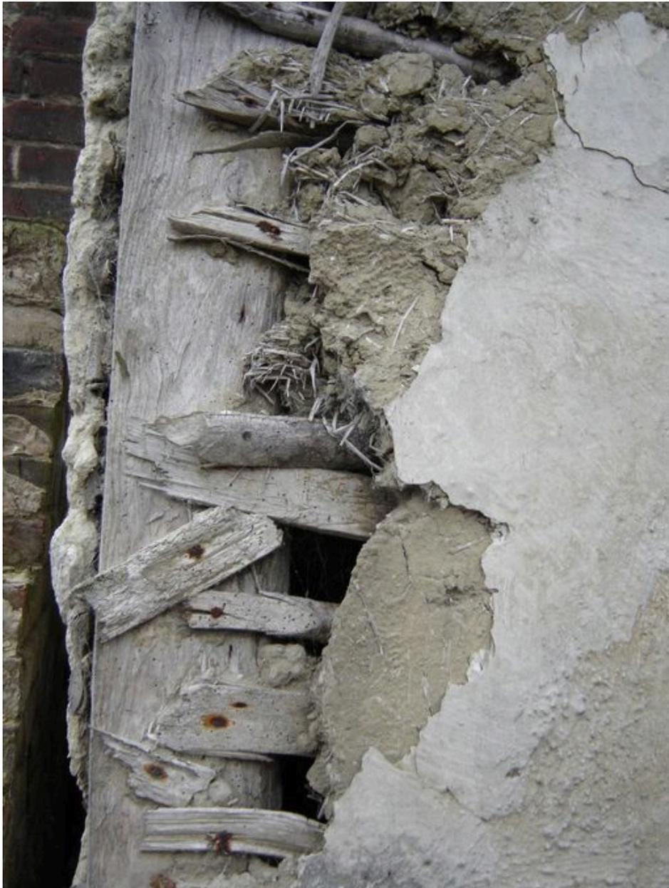
Vue détaillée du système de torchis et pans de bois : une grange proportion de paille est utilisée ici. La photo permet également de déterminer les différentes couches de finition.
