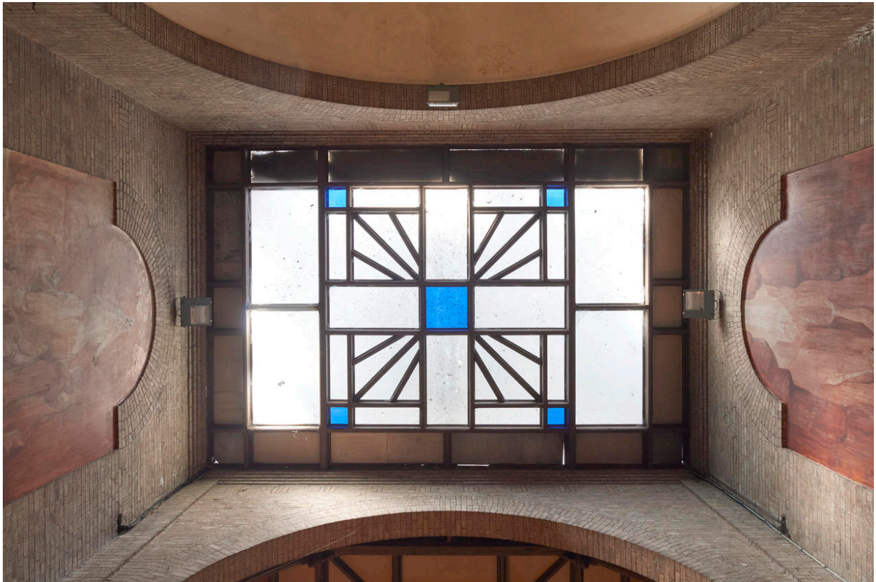
Vue du plafond en verre du chœur.
